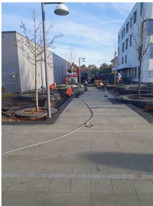
Kvernevik torg, belegg mellom svømmehallen og bydelshuset
