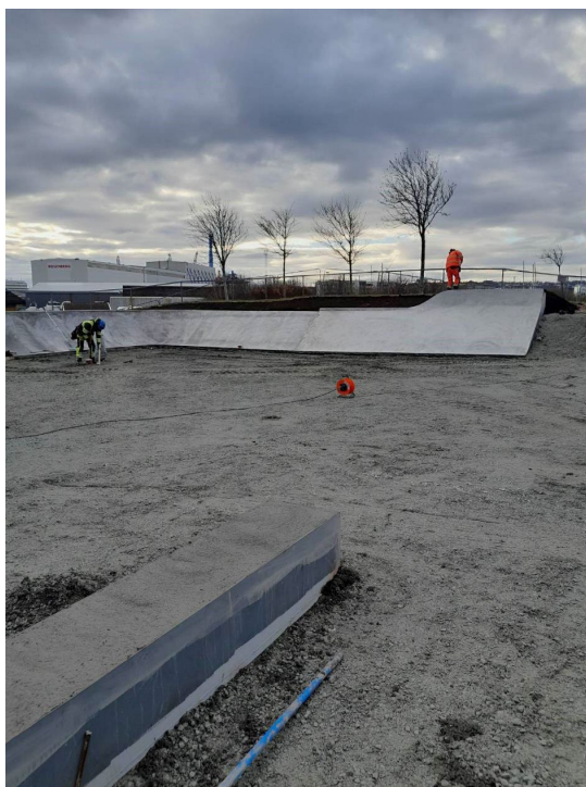
Bygging av skateanlegg Bangarvågen Hundvåg
