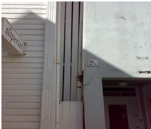
Tetting av smug/mellomrom FØR
