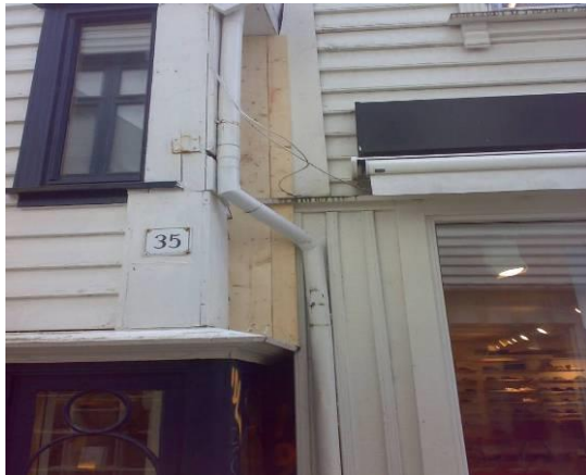
Tetting av smug/mellomrom FØR
