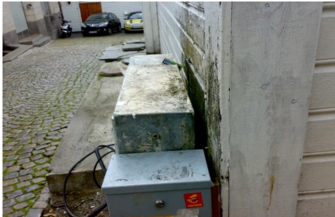
Tetting av el. skap FØR
