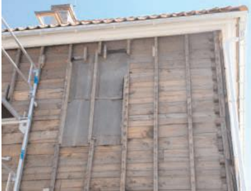
Husene ligger tett i tett til smale gater og er gjennomgående oppført i laftet tømmer med trekledning. Det er stedvis store terrengforskjeller og vanskelig tilgjengelighet. Blåsenborg.
