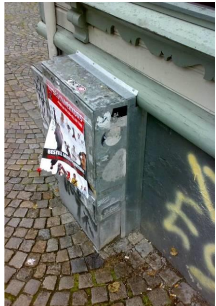
Tetting av el. skap ETTER
