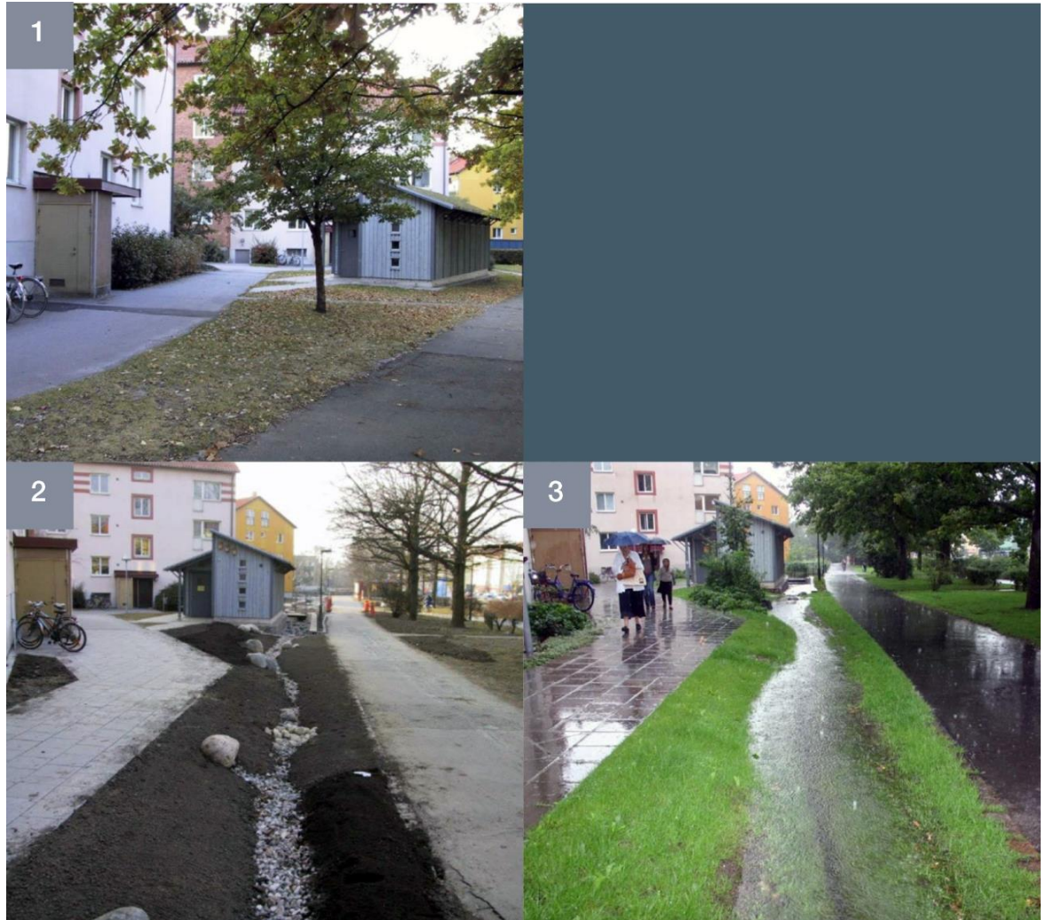
Figur 5-7 Eksempel på ettermontering av flomvei i eksisterende boområde (Augustenborg Malmø). Foto 1 viser førsituasjonen, foto 2 etter bygging av flomveien og foto 3 viser flomveien i funksjon ved kraftig nedbør. (Foto: Malmø kommune).
