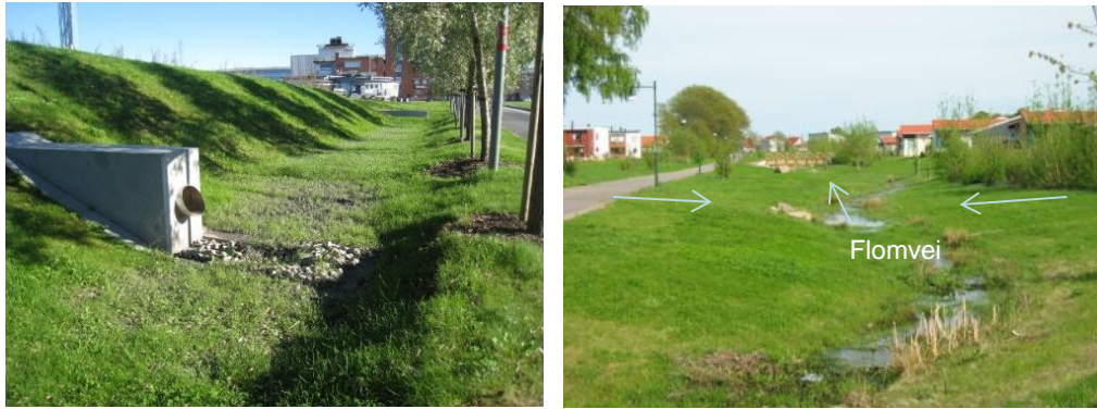
Figur 5-3 Eksempel på nedsenket grøntstruktur utformet for magasinering og infiltrasjon av overvann/flovvann fra et veianlegg, Fornebu (venstre foto). Gjennomgående grøntstruktur i bebyggelse utformet for overvannshåndtering og flom, Mariastaden i Helsingborg (høyre foto) (foto; COWI).
