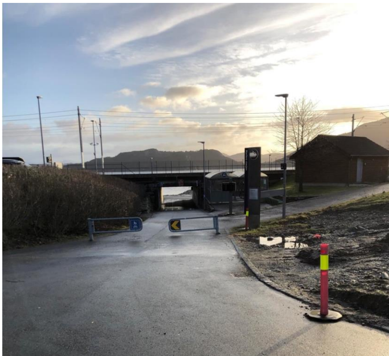
Figur 5-34 Kulvert under jernbanen som ser ut til å være godt tilpasset flomvei
