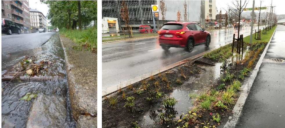
Figur 5-5 Gater er egnet for trygg bortledning av flomvann (venstre). Overvann og flom håndteres i nedsenket grøntrabatt mellom kjørebane og g/s-vei, Bjørnstjerne Bjørnsons gate Drammen (høyre) (Foto; Tharan Fergus/Ane Kirstine Laukli).
