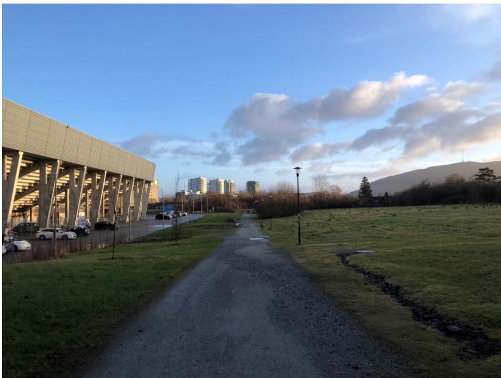
Figur 5-26 Grøntdraget langs sørlige del av Viking stadion kan fungere som flomvei hvis terrenget senkes (foto; COWI).
