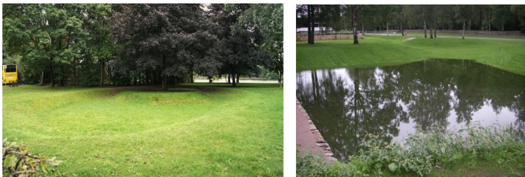
Figur 5-2 Nedsenkede områder i grønt-/parkområder tilrettelagt for kontrollert oversvømmelse. Til venstre fra Berlin og til høyre fra Växjö etter en regnhendelse (foto; Drammen kommune og Göran Lundgren).
