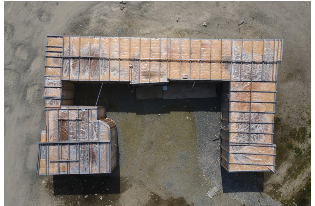
Konstruksjonen på Ventetomt, TOU sett ovenfra
