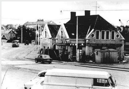
Her er den sydlige delen av territoriet vårt. Her holdt Rogalend Politikammer til, Dette er krysset der Vålandsgaten traff Lagårsveien.
