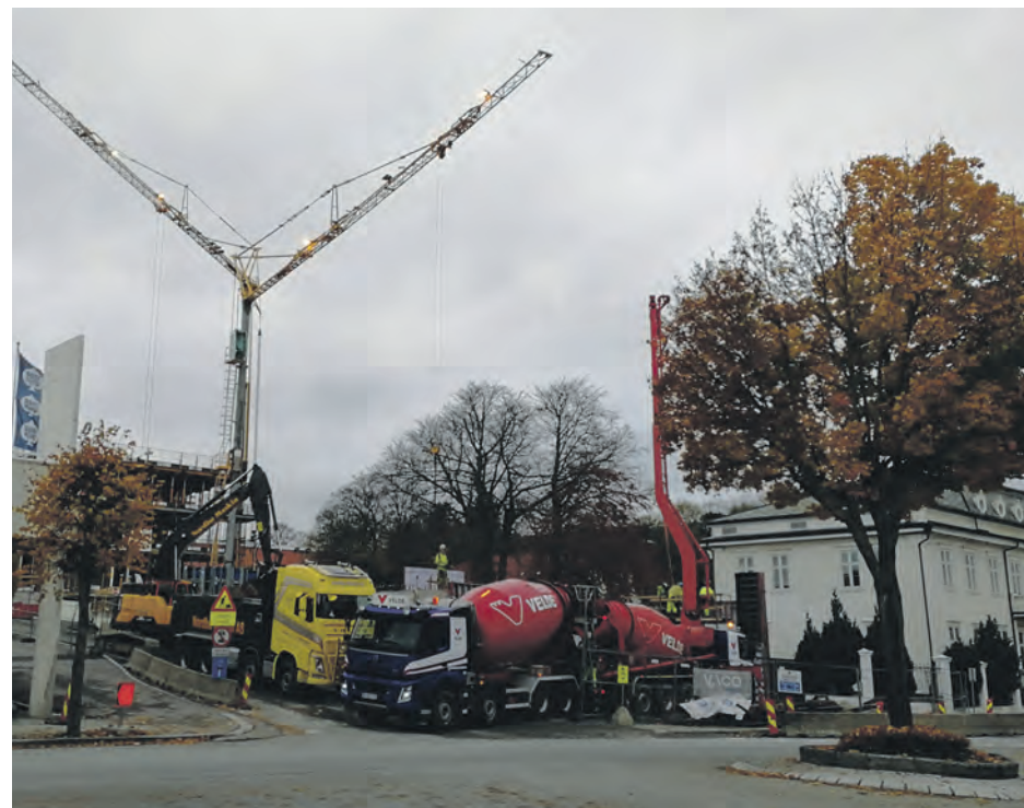
-Bate bygger 42 leiligheter i Fridas hage som vil bestå av to bygg. Bildet viser arbeid på bygg B. Det er nå solgt 29 av de 42 leilighetene. De skal være klare for
