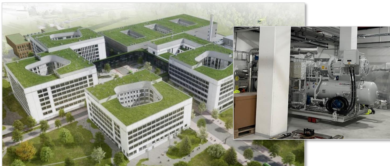
Figur 41 Nye Stavanger Universitetssykehus (Nye SUS) har flere bergvarmepumper som er tilknyttet 130 energibrønner i fjell (brønnpark). Installasjon av ammoniakk varmepumpeaggregat i termisk energisentral (illustrasjon/bilde – Helse Stavanger HF, 2022).
