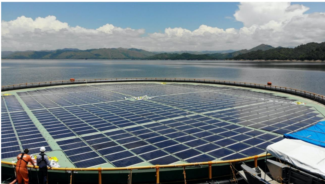
Figur 30: Illustrasjonsbilde av flytende solkraft med installert effekt på 220kWp utført av norske Ocean Sun [40]
