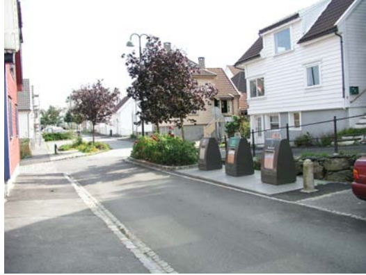
Fig. 2.28 Ny renovasjonsløsning i sentrumsnære områder.. Nedgravde avfallsbeholdere er brannsikre, plassbesparende og hygieniske.
