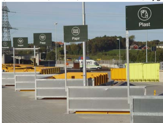
Fig. 2.25 Forus gjenvinningsstasjon.. Innbyggerne selv sorterer og leverer avfall.
