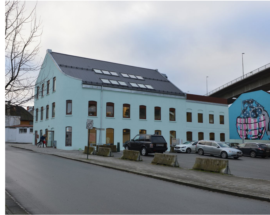
Absinthen i Nedre Banegate 41, er en av bygningene fra hermetikkepoken som er gitt nytt og aktuelt innhold. Sentrumsplanen har føringer for bevaring av flere bygg i denne gata, som til sammen forteller om sentrums og byens historie.
