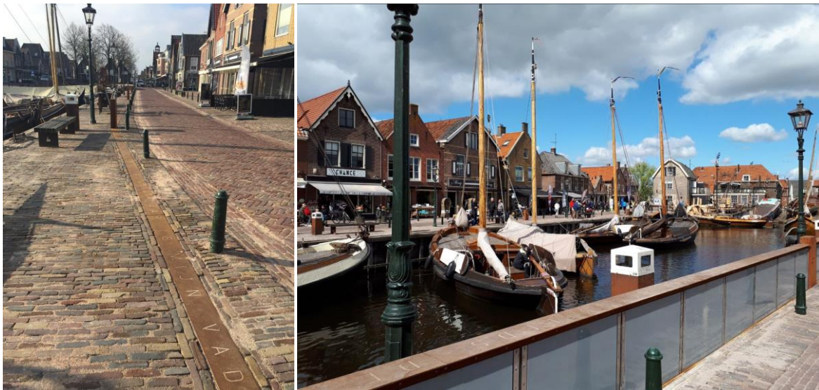
Figur 5 Eksempel på fleksibelt flomvern fra Spanburg i Nederland. Flomvernet består av en kant som heves ved behov, bilder fra google
