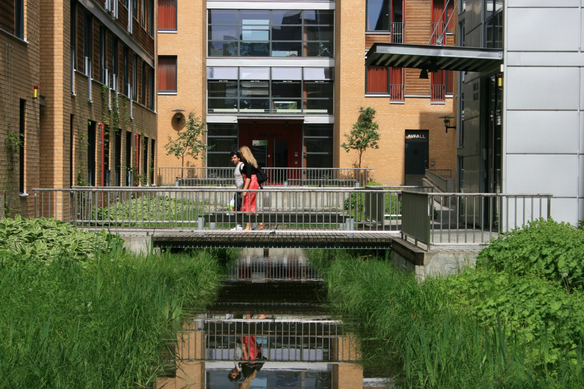
HÅNDTERING AV OVERVANN. KVARTALSKANALEN PÅ BJØLSEN STUDENTBY, OSLO ARK TELJE TORP AASEN. LARK SNØHETTA (foto: Rainer Stange/Dronninga Landskap)
