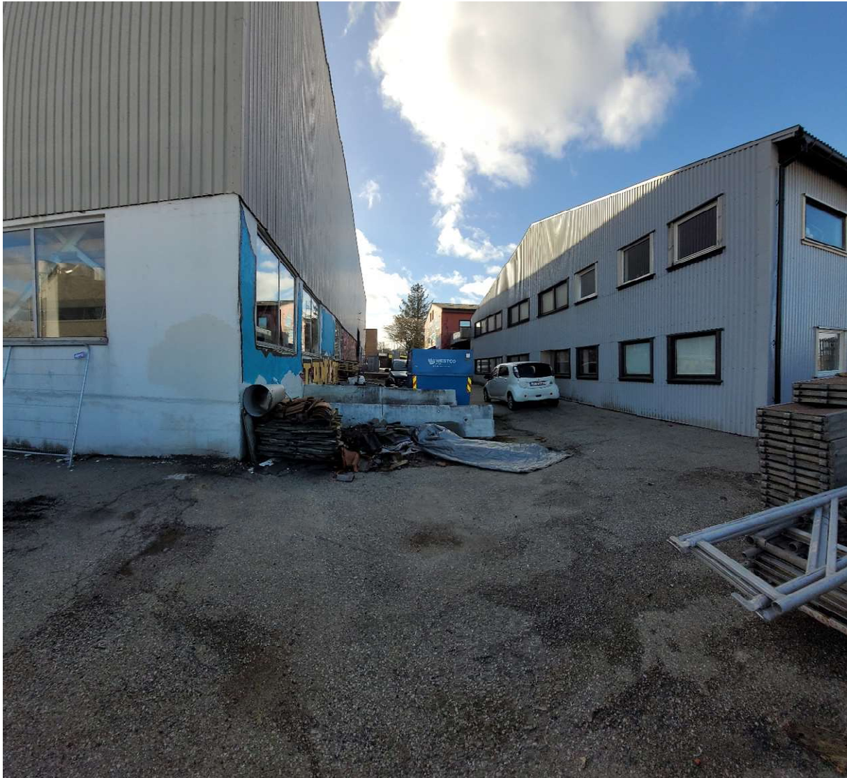
Sørøstre hjørnet av Tilbygg Flintegata 2 og nordøstre hjørnet av Flintegata 4
