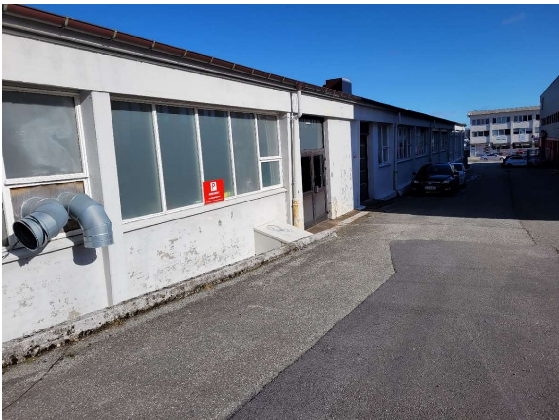
Østre del av fasade mot sør
