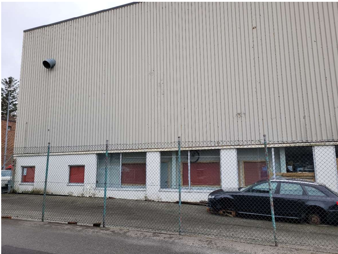
Grunnmur nordvegg – vestre del
