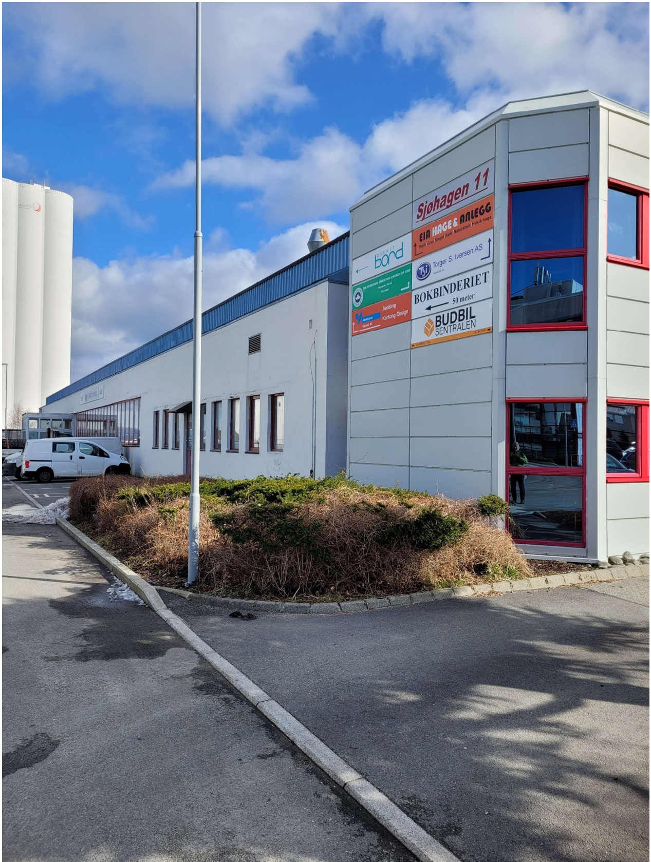
Tilbygg og opprinnelig bygg - Sørvegg
