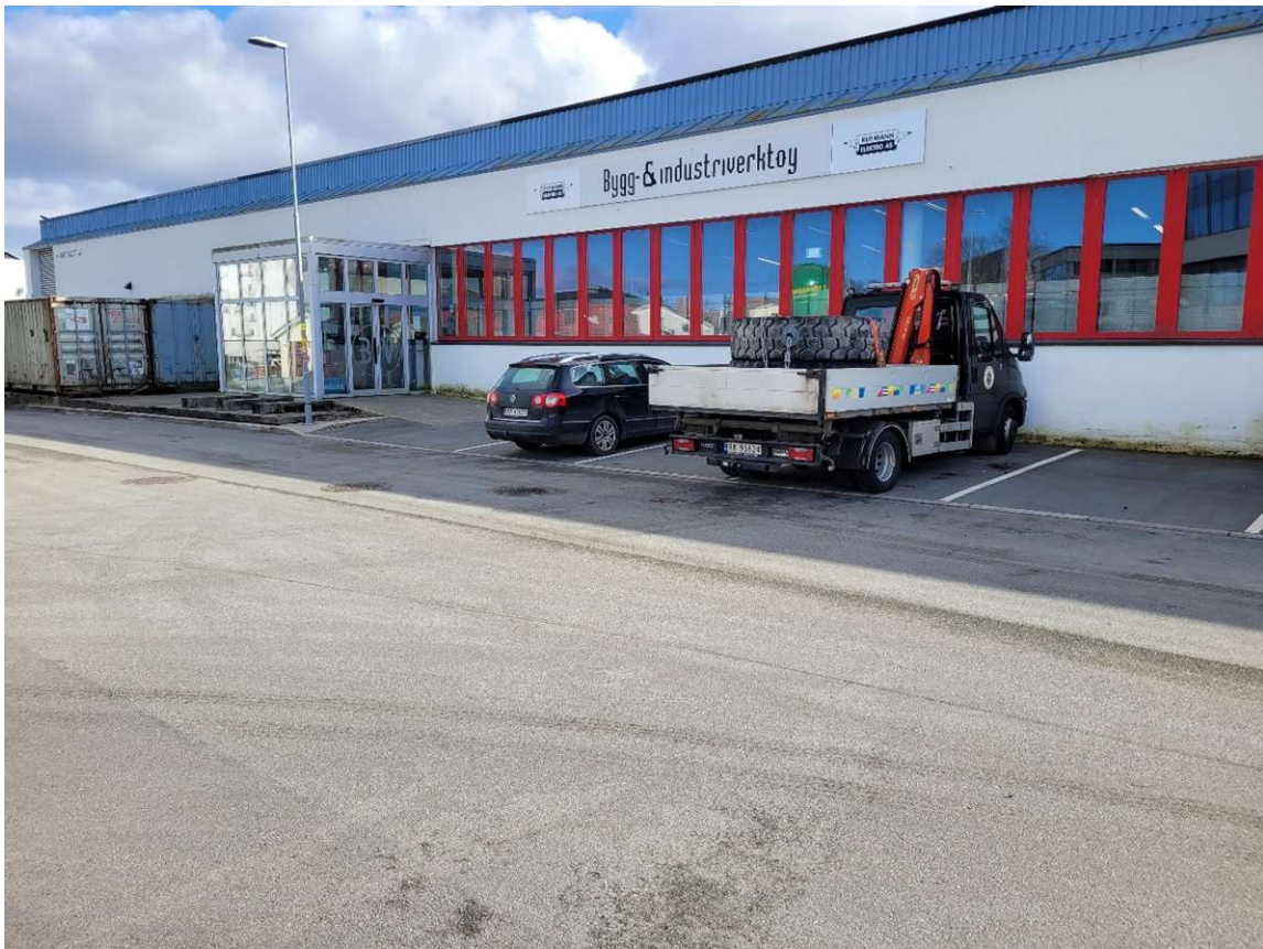
Opprinnelig bygg – deler av sørvegg
