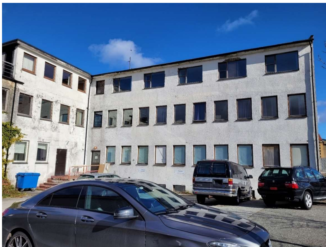
Vestre fasade på opprinnelig bygg, og søre fasade på tilbygg
