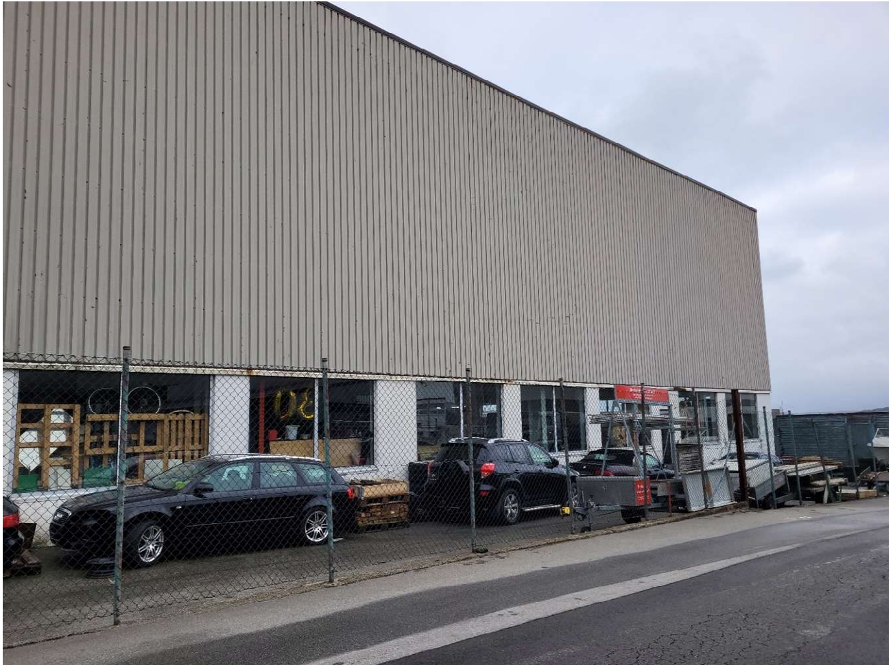
Grunnmur nordvegg – østre del
