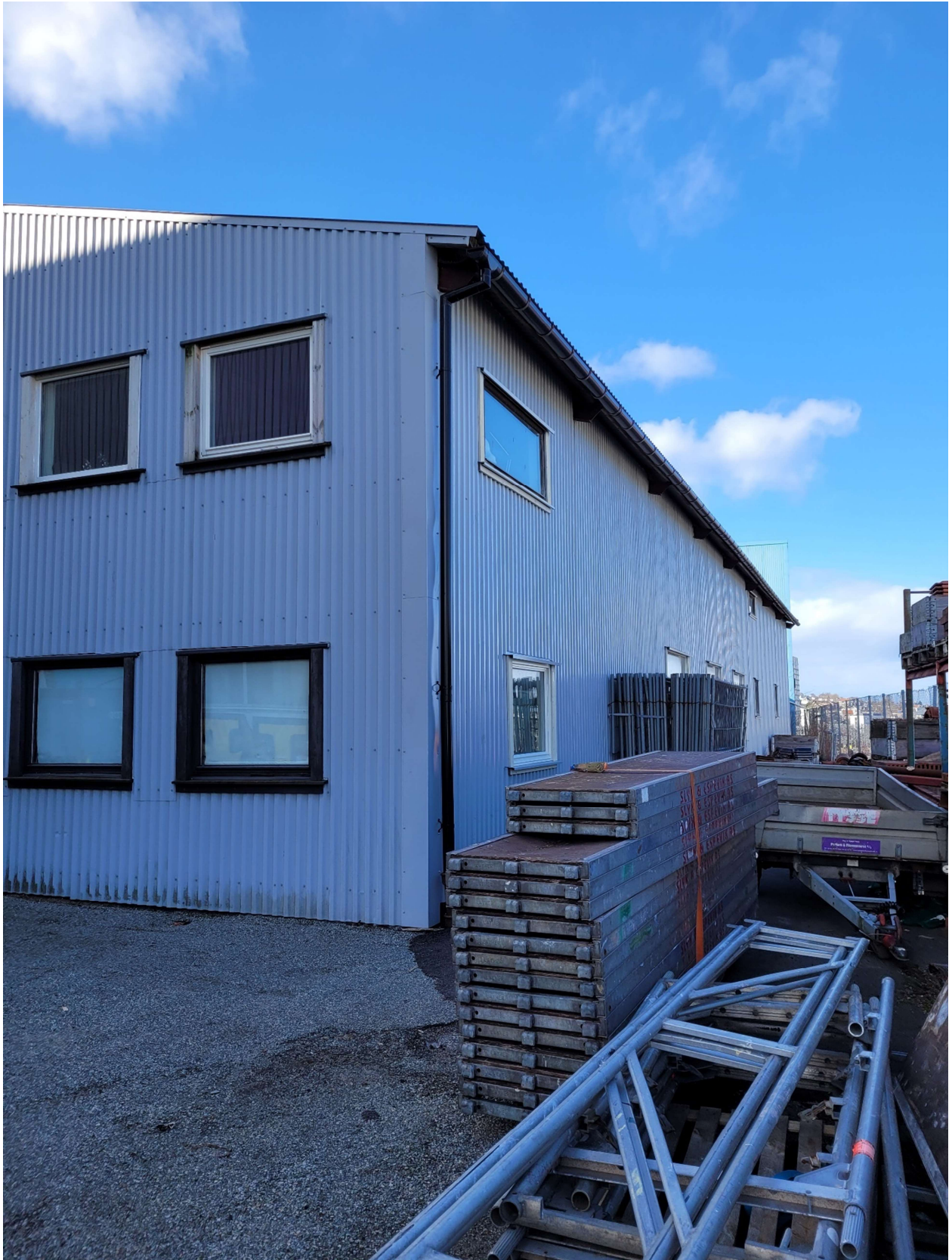
Tilbygg – sør-østre hjørne
