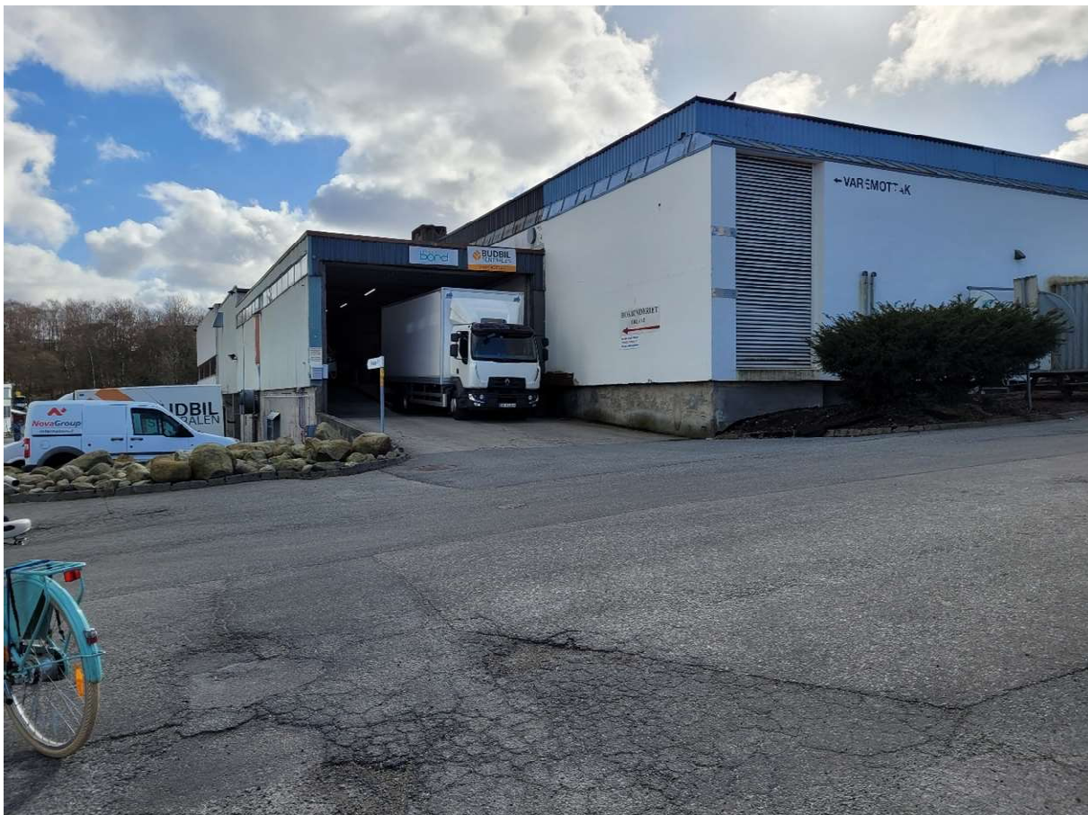
Østvegg og del av sørvegg opprinnelig bygg
