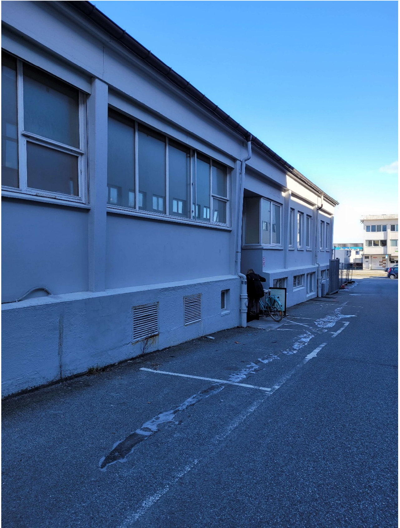
Østre del av fasade mot sør
