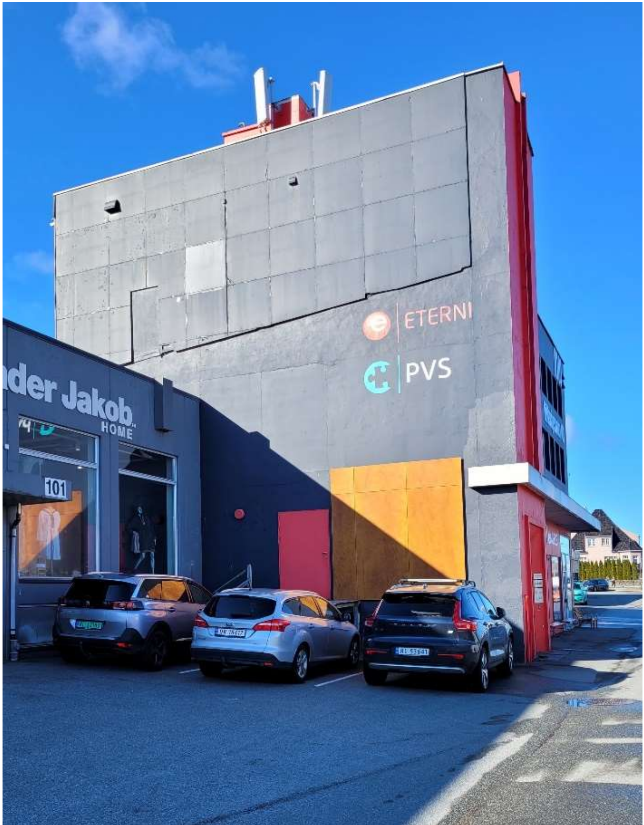
Søre fasade hovedbygg
