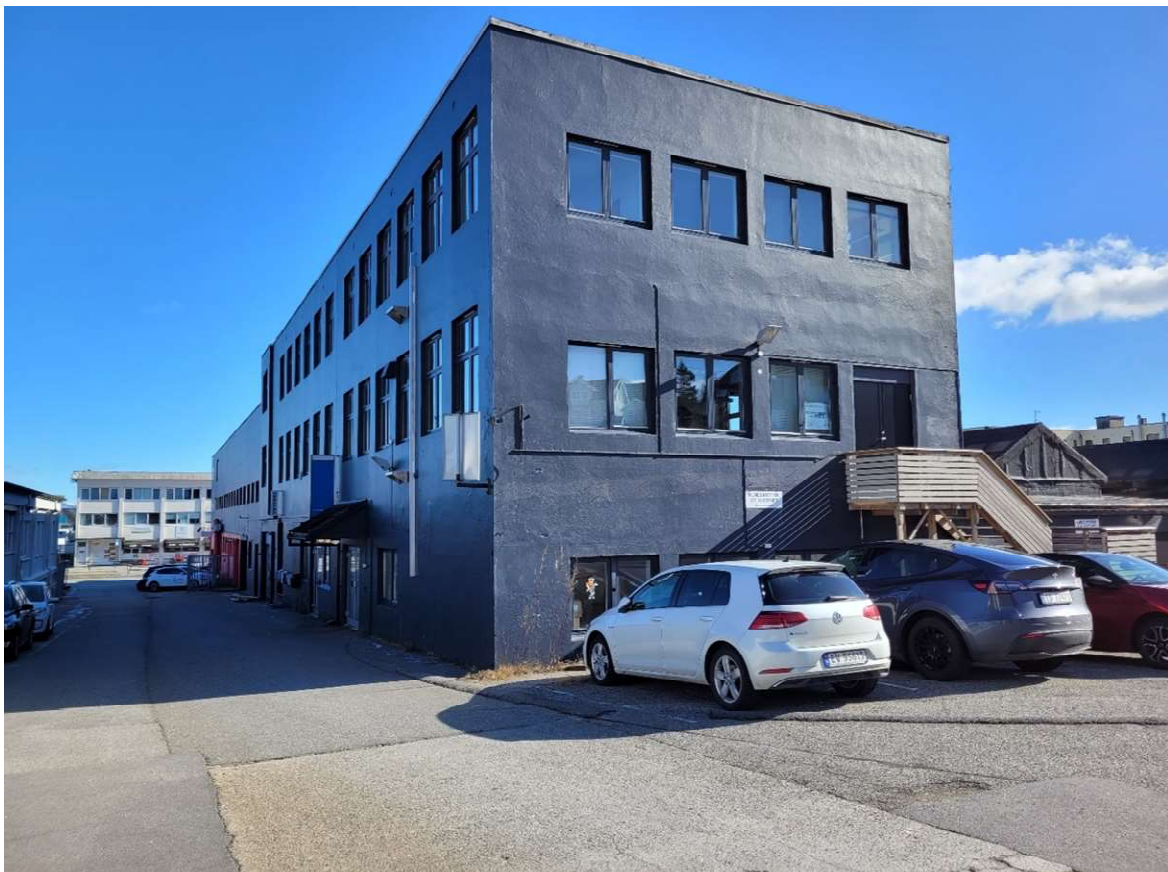
Nordvestre fasade tilbygg
