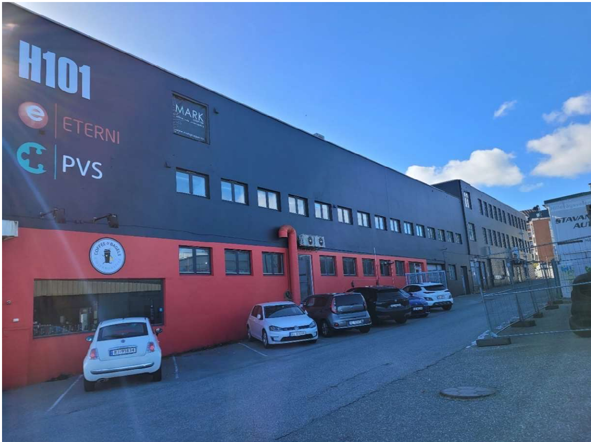
Nordre fasade hovedbygg og tilbygg
