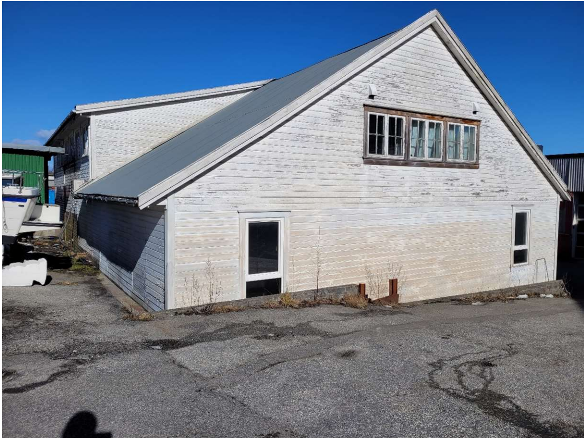
Søre og vestre fasade første bygg
