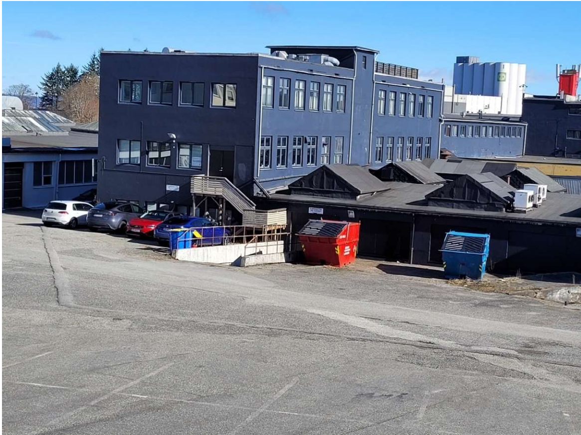
Vestre og søre fasade tilbygg
