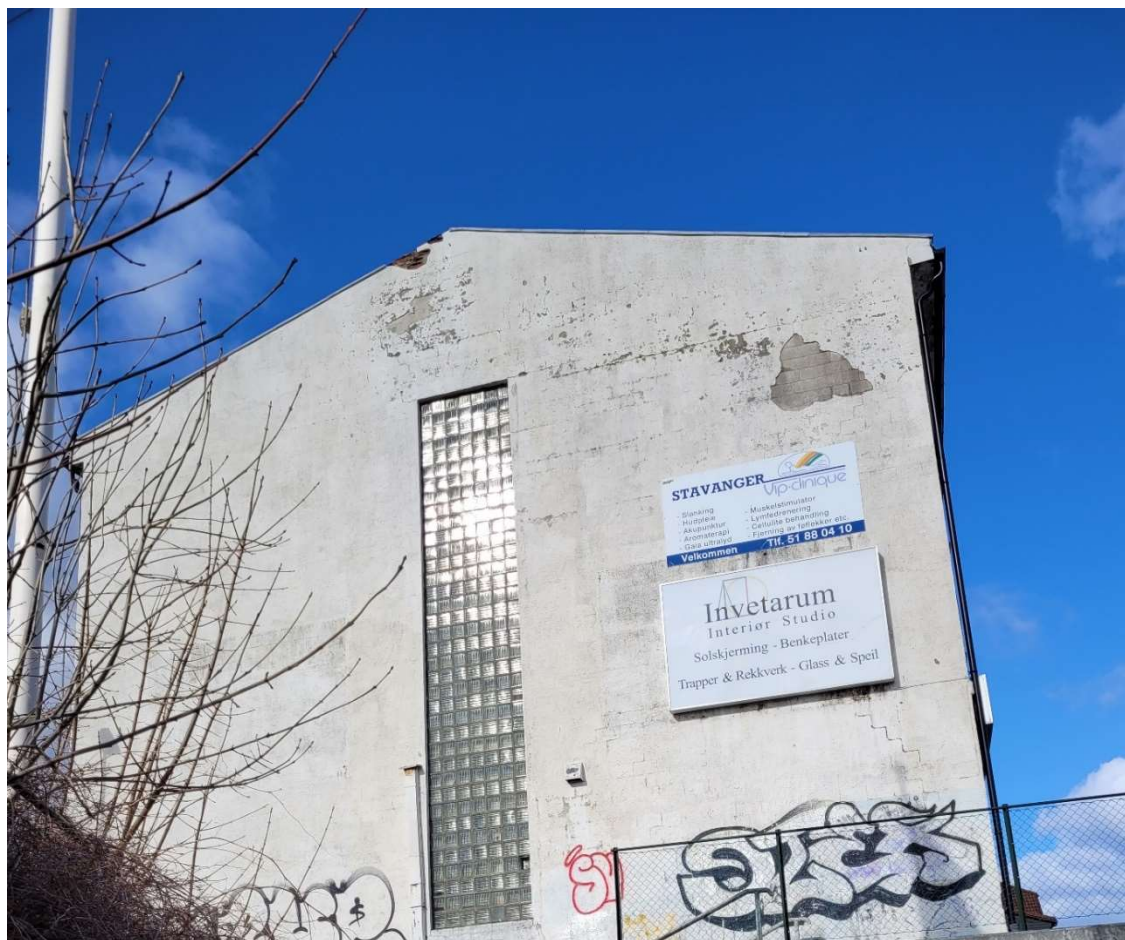
Søre fasade på opprinnelig bygg
