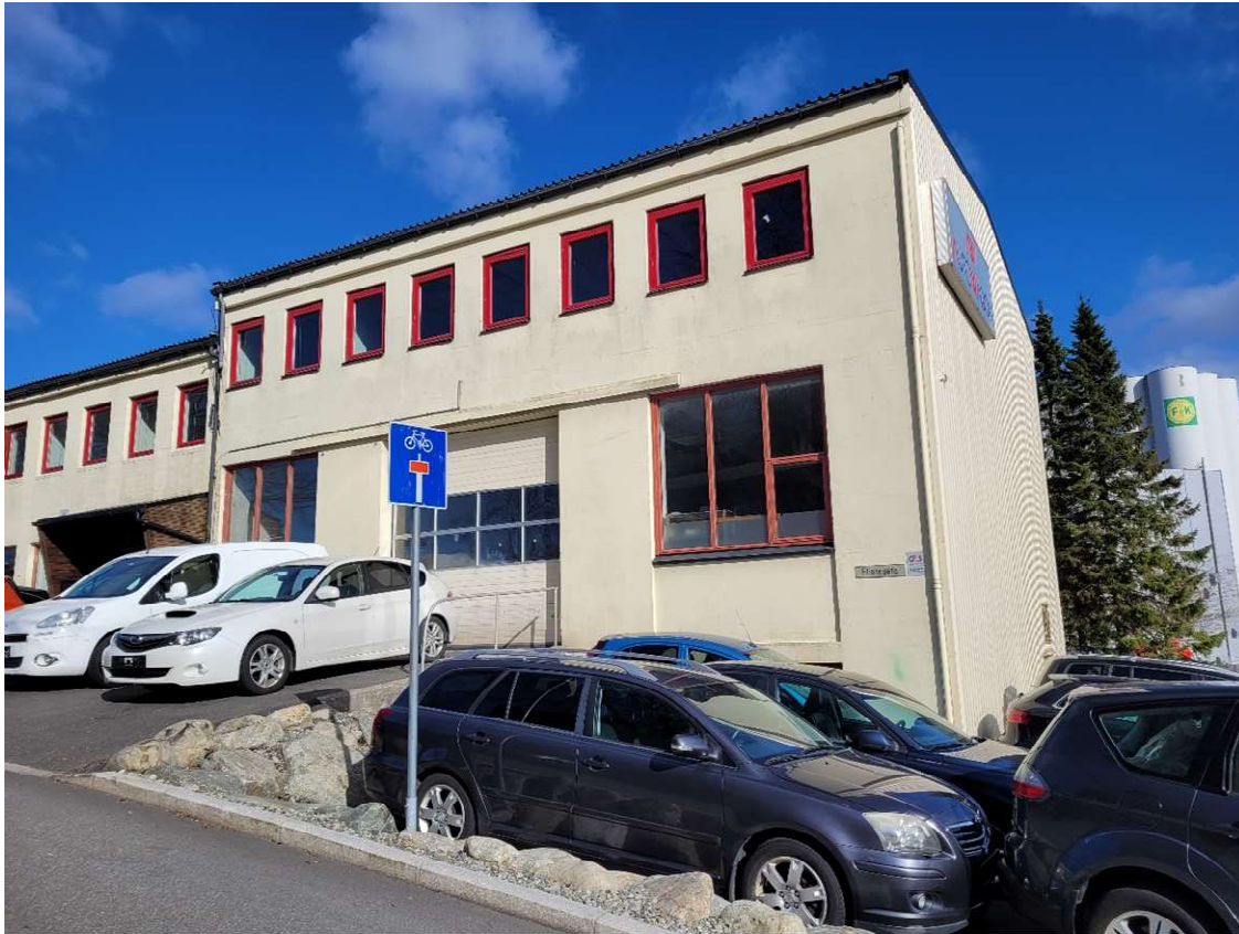
Søndre del av vestvegg- og sørvegg
