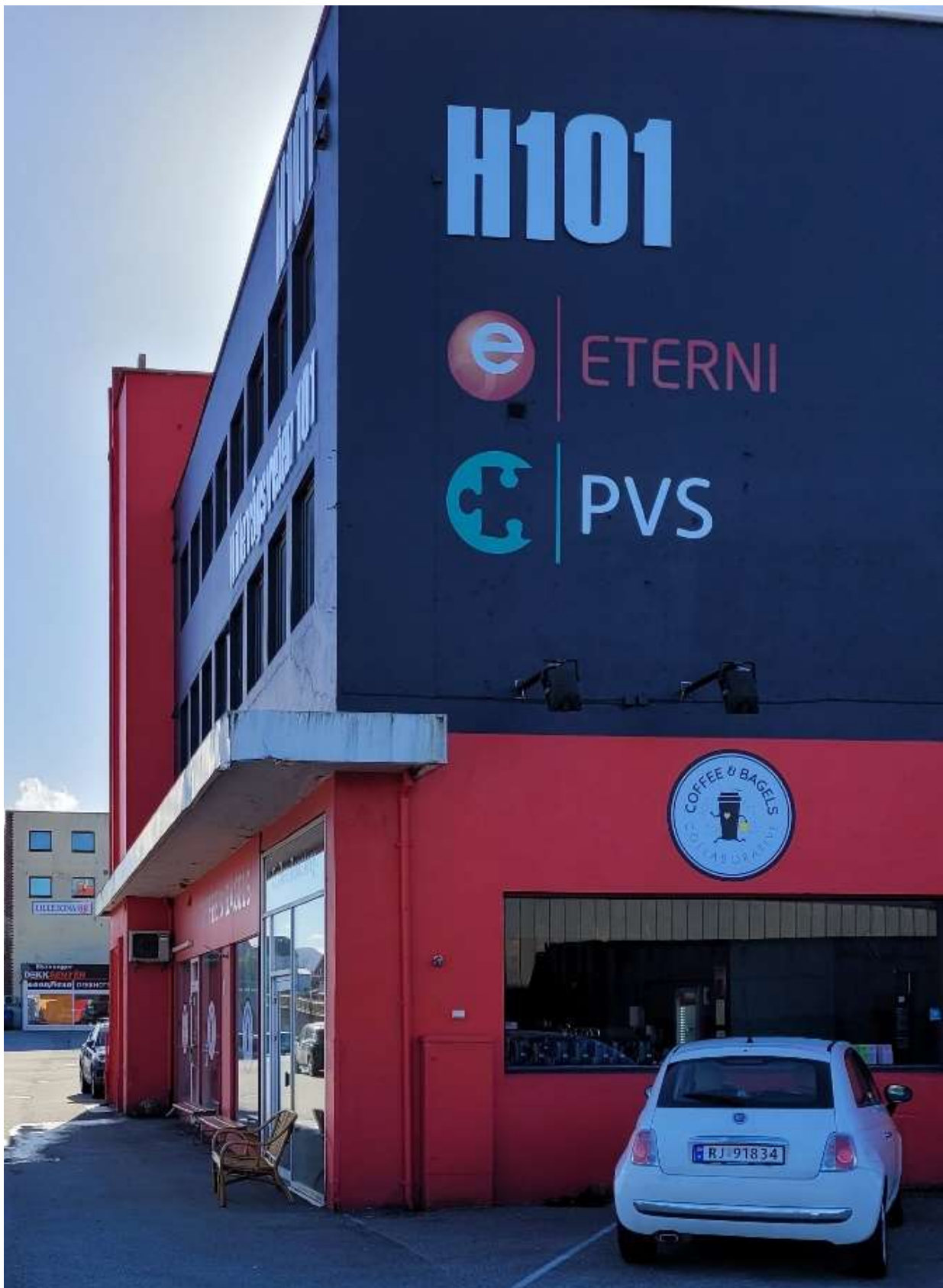
Norøstre hjørne hovedbygg
