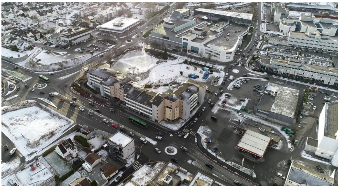
Figur 2: Utklipp fra en av dronefilmene, som illustrerer området det er gjort trafikkregistreringer i.
