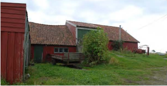
L. Gårdsbruk. Driftsbygning fra ca. 1880 og våningshus fra 1830
