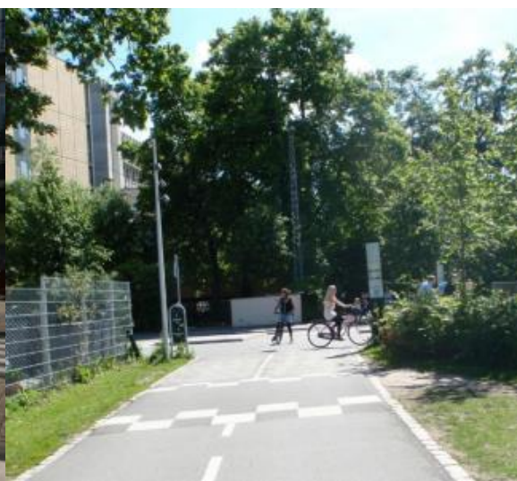
Figur 42 Bruk av fartsdumper og rumlefelt for å redusere sykkelhastighet inn mot krysningspunkt (Sykkel og gange i by og tettsted, Statens vegvesen 2014. Foto: Tine Solem)
