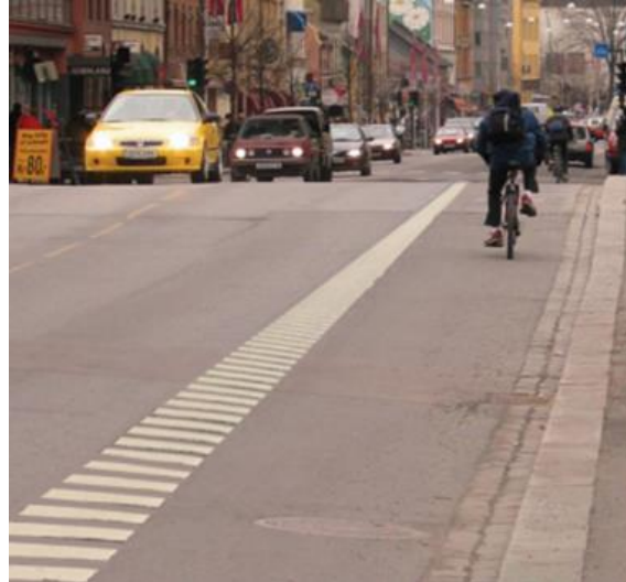
Figur 33 Etablering av rumlestripe mellom bil- og sykkelfelt for å øke sikkerheten (Foto: Sykkel og gange i by og tettsted, Statens vegvesen 2014)
