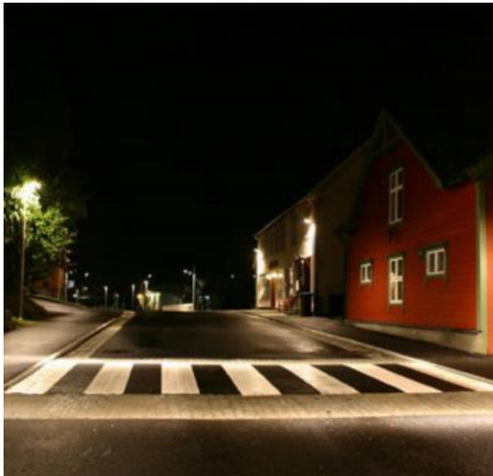
Figur 47 Eksempel på opphøyd gangfelt (Sykkel og gange i by og tettsted, Statens vegvesen 2014)
