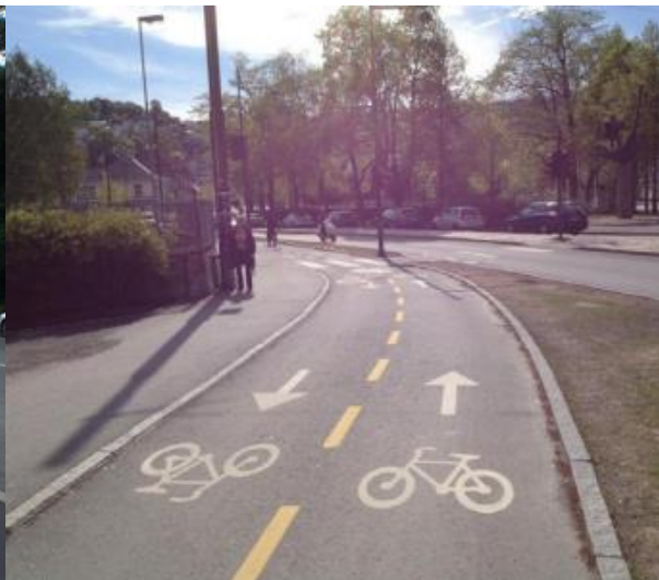
Figur 35 Separat gang-/sykkelvei med fortausløsning ( Sykkel og gange i by og tettsted , Statens vegvesen 2014)
