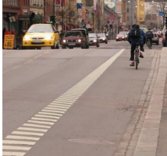
Figur 33 Etablering av rumlestripe mellom bil- og sykkel felt for å øke sikkerheten (Foto: Sykkel og gange i by og tettsted, Statens vegvesen 2014)
