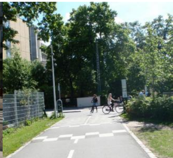
Figur 42 Bruk av fartsdumper og rumlefelt for å redusere sykkelhastighet inn mot krysningspunkt (Sykkel og gange i by og tettsted, Statens vegvesen 2014. Foto: Tine Solem)
