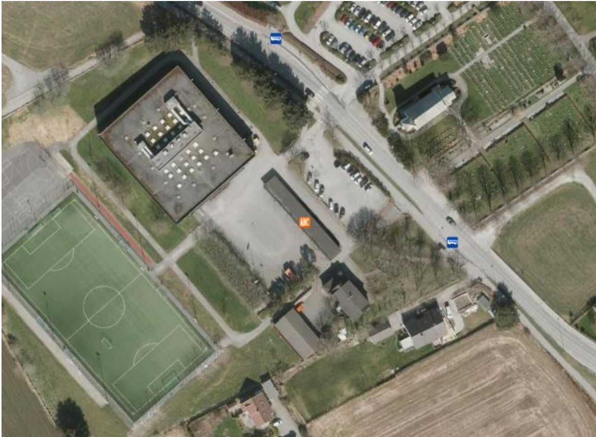
Figur 123 Strekning forbi Revheim skole og kirke hvor det vurderes å etablere kulvert for gjennomgående biltrafikk (Kart: Finn.no)
