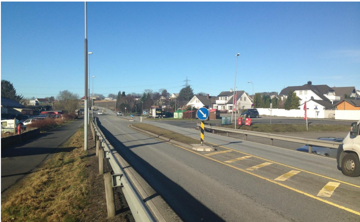
Figur 2 Dagens utforming av rv. 509 Revheimsveien (Foto: Stavanger kommune)
