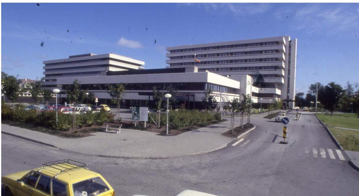
Figur 20 - De nye fløiene og parkeringshus ferdigstilt. Sett fra den nye hovedinnfartsåren i vest.
