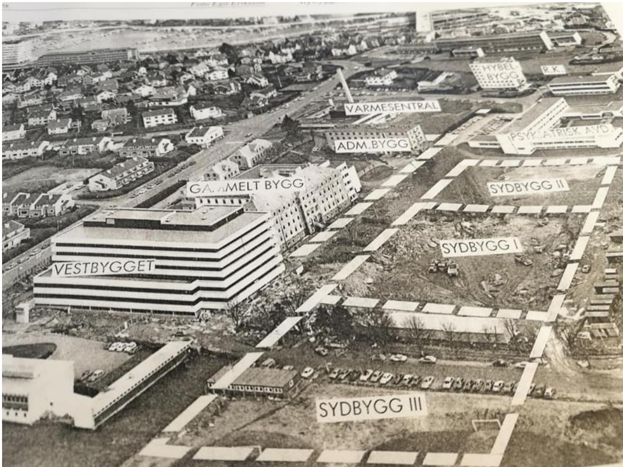
Figur 19 - Hovedbygget ("gammelt bygg") er i ferd med å forsvinne i mengden
