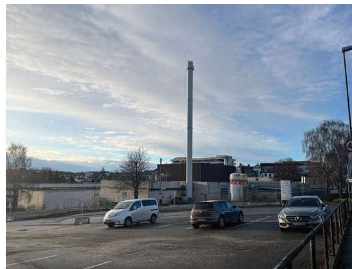
Varmesentralen er en lokal støykilde.
