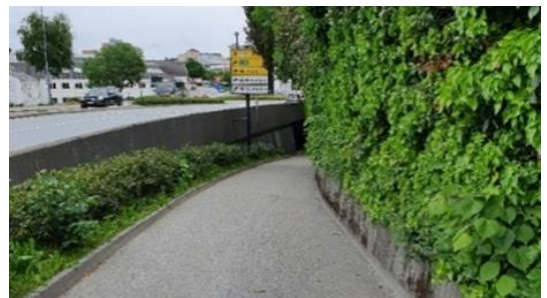
Figur 8. Det er dårlig sikt ned til undergang ved Hillevågstunnelen.
