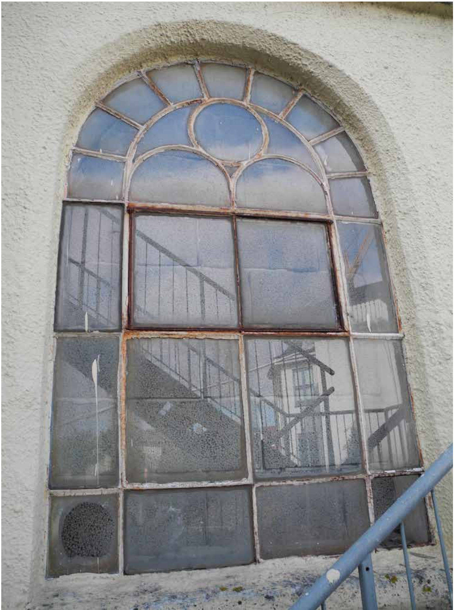
Støpejernsvindu. Karakteristisk for industriarkitekturen. Foto: Byantikvaren
