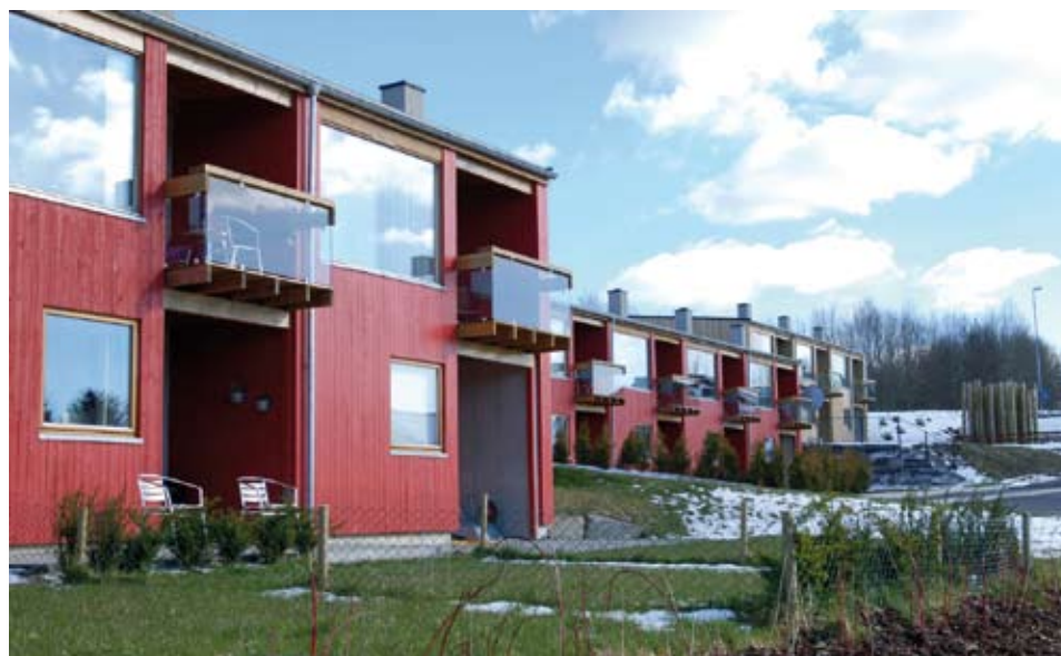
Rekkehus under oppføring våren 2008.
