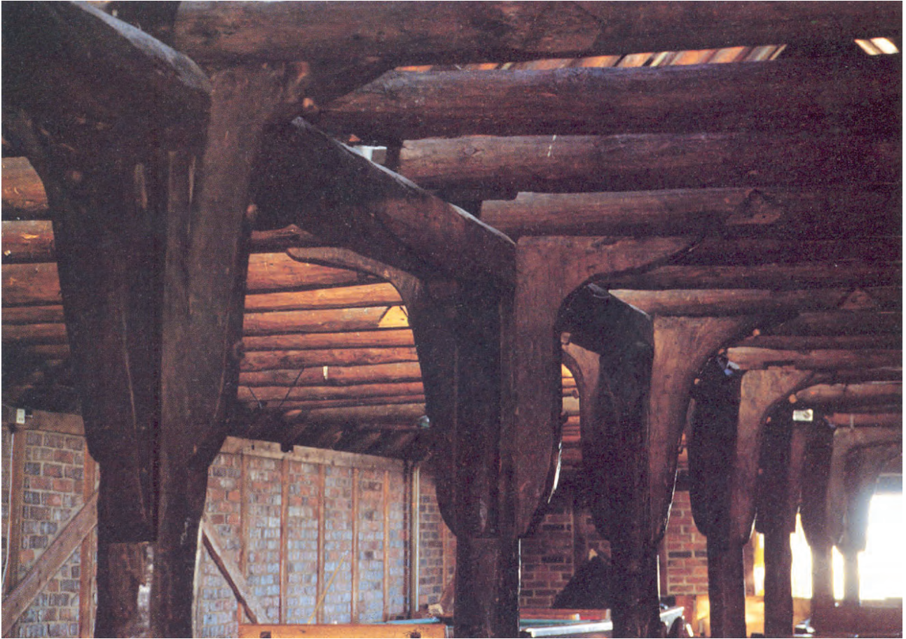
Interiør Nedre Holmegate 12-20. Den karakteristiske avsstivningen med krumvokste knær. Foto: Helge Schjelderup.
