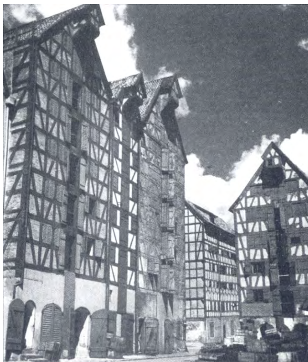
Sjøhus i utmurt bindingsverk i Kilingrad (tidl. Øst-Preusen) fra 17.-18. århundre. (Deutsche Fachwerkbauten, Herman Phlebs.)
