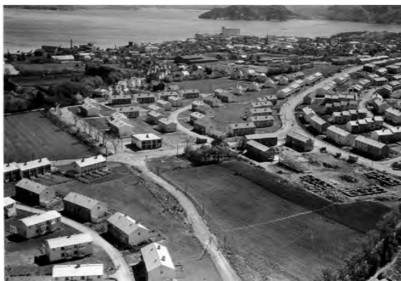
Hillevåg sett sørøst. Bekkefaret i forgrunnen. Svend Foyns gate er opparbeidet og bebyggelsen følger terrengekurvaturen. Sammenlikn med bildet på side 12. Byarkivet .
