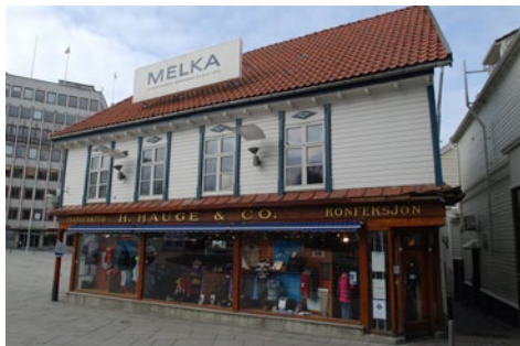
Skilt på takflate er ikke tillatt.
