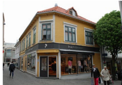
Skilt over vindusrekken er historisk korrekt.
