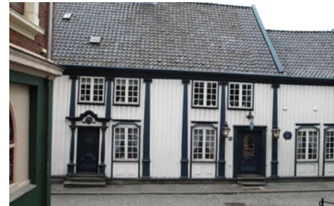
Skagen 18, Hansen-huset. Barokk/rokoko. Eldste deler er fra 1720, påbygd ca 1850. Fredet.
