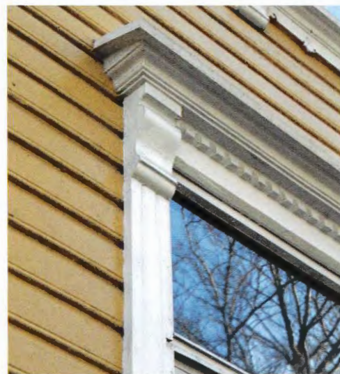
Snitt av listverk som er laget av gulvbord med L1 øverst
