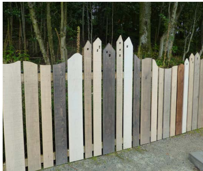
Bilde 22: Barnehagegjerdet kan utformes på mange måter. Det er allikevel nødvendig å tenke over sikkerhet, levetid, riktig bruk av materialer og vedlikehold.
