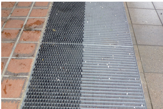
Bilde 44: Rist ved inngangssonen letter vedlikeholdet og hindrer slitasje på innvendig bygg.
