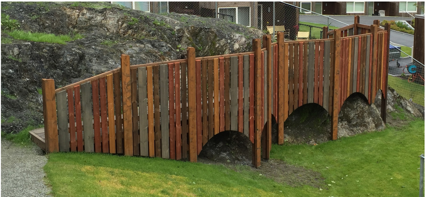
Bilde 4: Her har en bratt skråning blitt trygg og gitt økt areal som kan brukes til lek.
