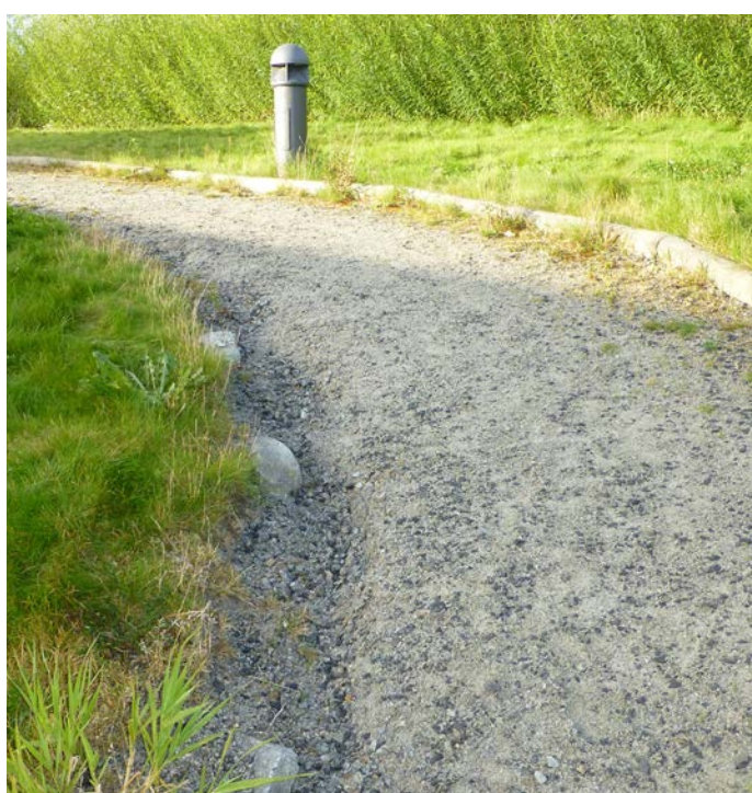
Bilde 49: Bratt skråning med grus som eroderes når det regner. Det gir utvasking av grus som samler seg nederst i bakken.
