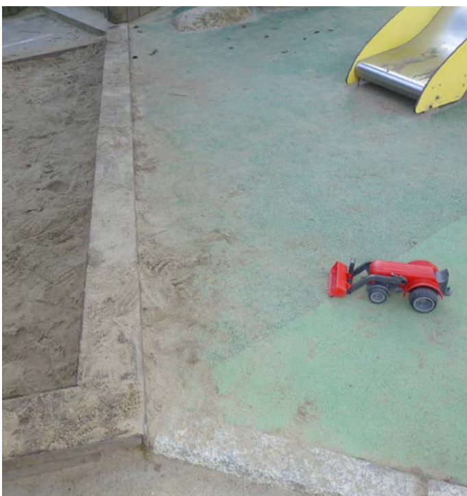
Bilde 43: Sand som flyter utover på grunn av for lav kant på sandkassen.
