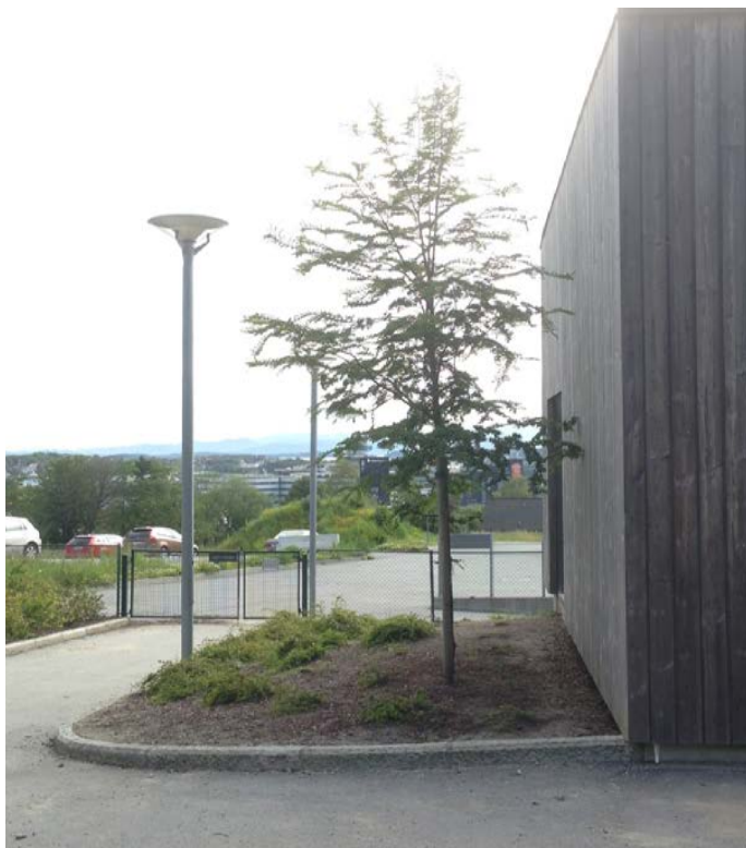
Bilde 27: Belysning ved inngangen. Her ser vi også at treet er plassert for nærme bygget.
