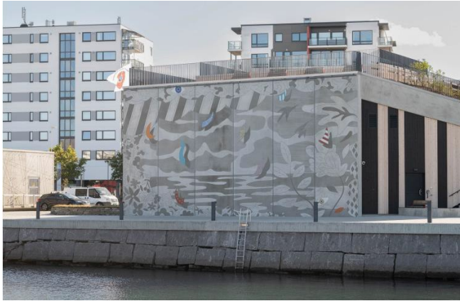
Fasadekunsten på Varmen brannstasjon
