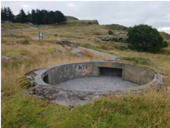
Luftvernstilling øst for toalettbygget ved hovedturvei
