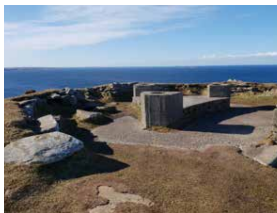
Luftvernstandplass på Fjøløyvarden. Her kan en enkel benkeplate mellom de tre toppene i betong være en mulig tilrettelegging.
