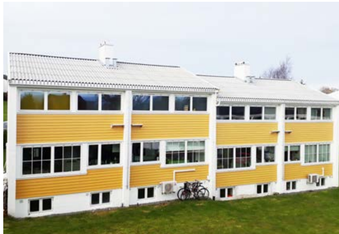
-I år har vi gjort et nytt stort løft med husene. Vi har byttet taktekkning til likt det originale taket, sier Asbjørn Bryne Hogstad.
