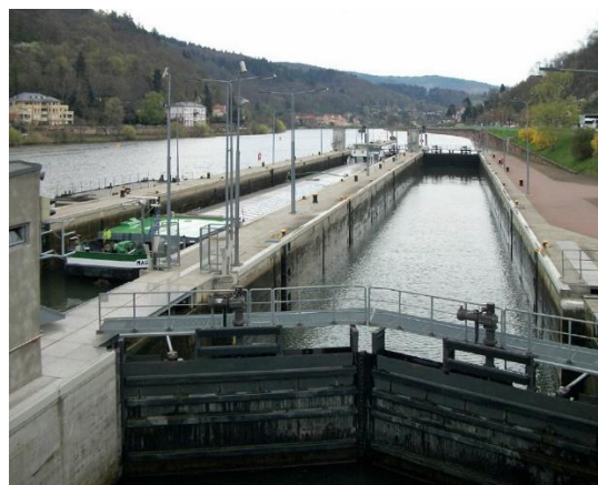
Figur 8-3: Eksempler på sluser: venstre: sluse som høyvannssikring ved Aabenraa med 1 dør, Danmark (COWI); høyre: sluse for skipstrafikk nær Heidelberg med 2 dører, Tyskland (public domain).
