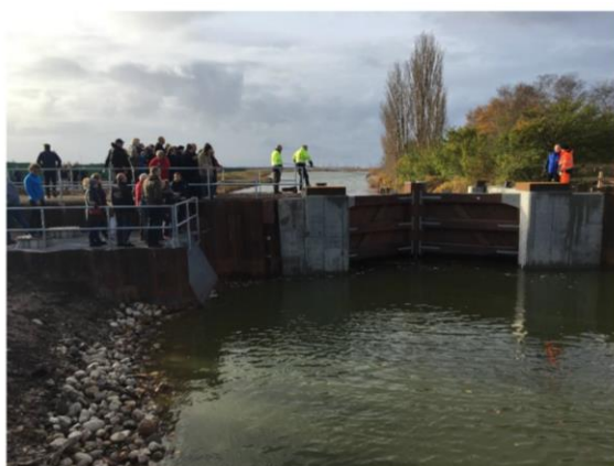
Figur 8-3: Eksempler på sluser: venstre: sluse som høyvannssikring ved Aabenraa med 1 dør, Danmark (COWI); høyre: sluse for skipstrafikk nær Heidelberg med 2 dører, Tyskland (public domain).
