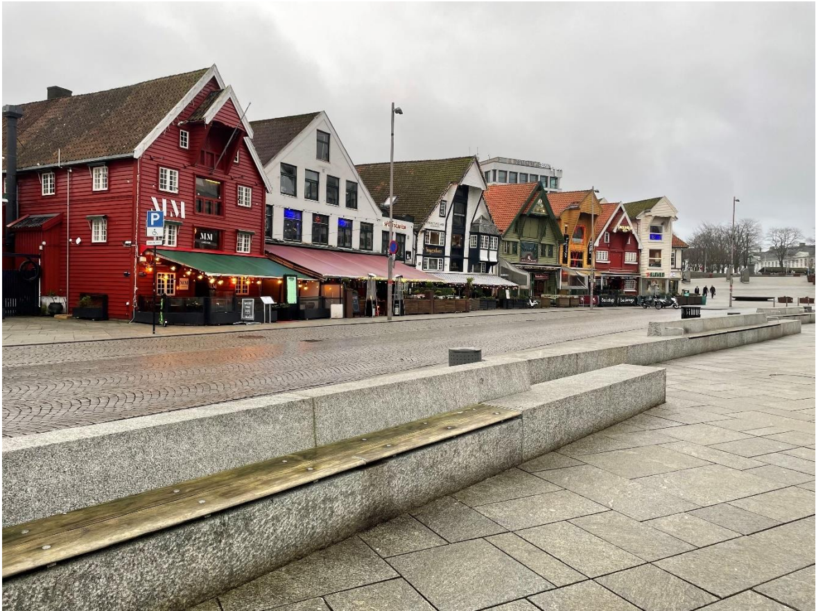
Figur 8-1: Lavtliggende historiske bygninger langs Skagenkaien. Foto: COWI
