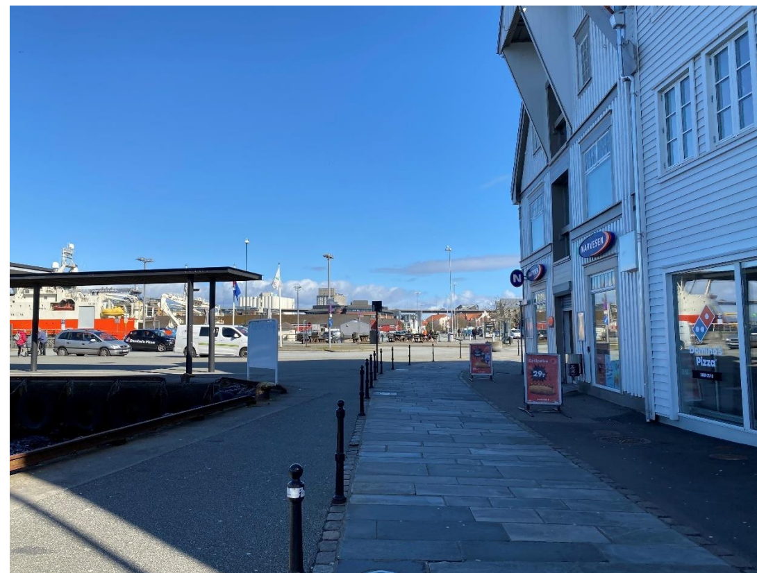
Figur 37 Foto fra kailinja ved Magasin Blå, mai 2020. Kablene ligger under det hellelagte dekket i bildet og går ut i sjøen til venstre.
