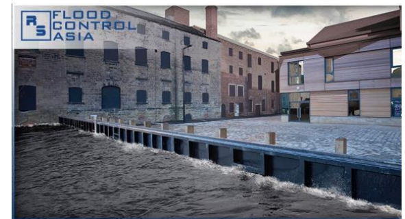
Figur 31 Stengbar åpning, "vippeprinsippet".
