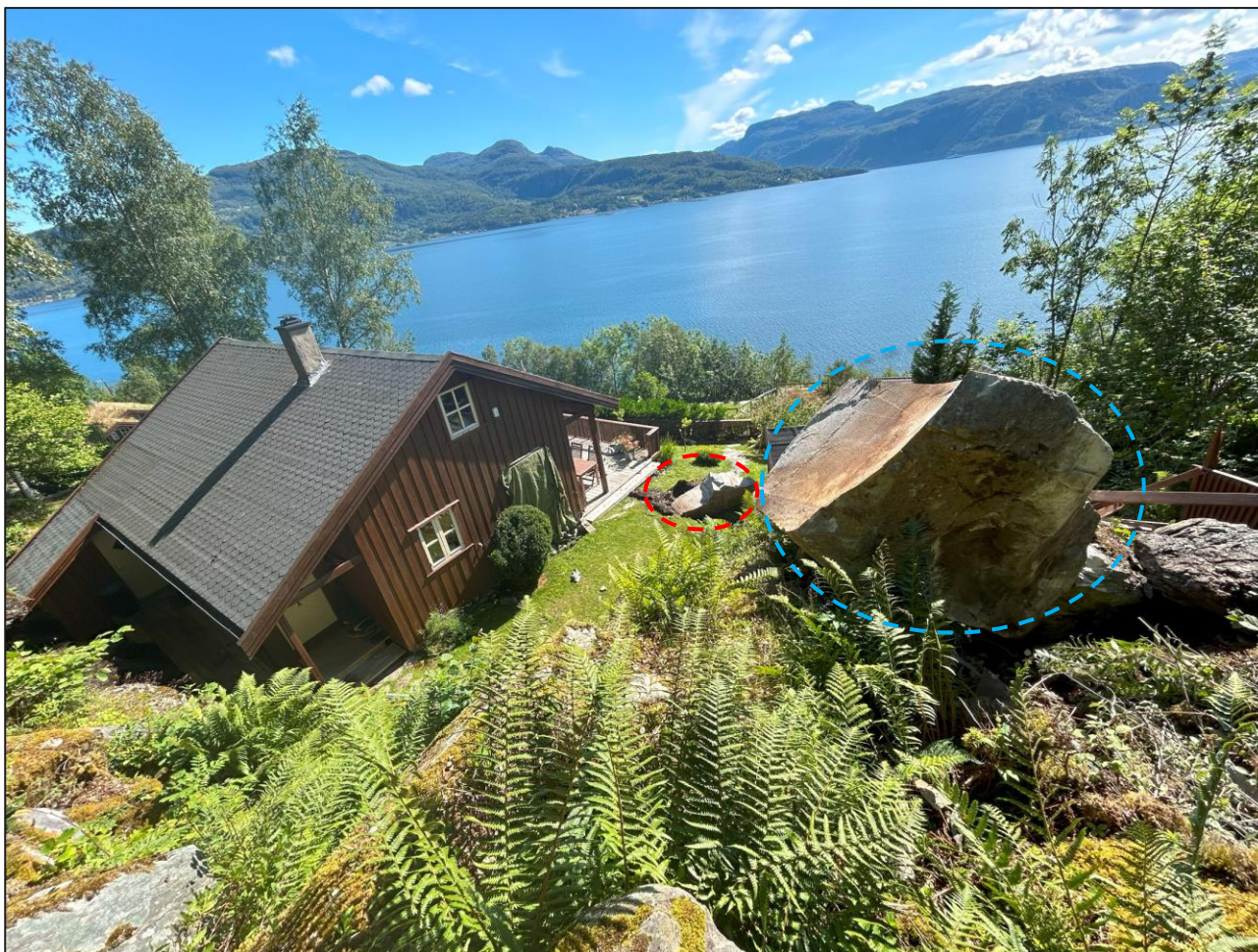
Foto 7. Blokk på anslagsvis 5 m 3 (blå ring) like ovenfor hytta. Det antas at blokken som er markert med rødt (ca. 1 m 3 ) har løsnet fra hovedblokka i sammenstøtet med eldre blokker på eiendommen. Tatt 09.07.2024.
