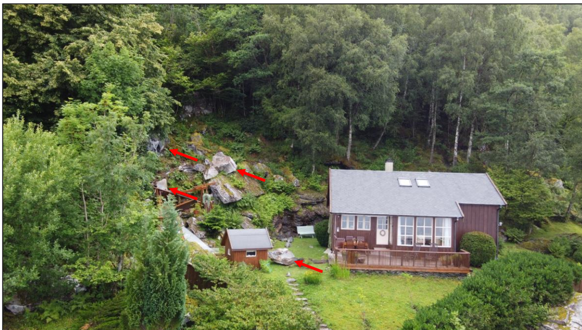
Foto 8. Dronebilde av Tjueneset 30. Pilene viser ferske skredblokker. Tatt 12.07.2024.
