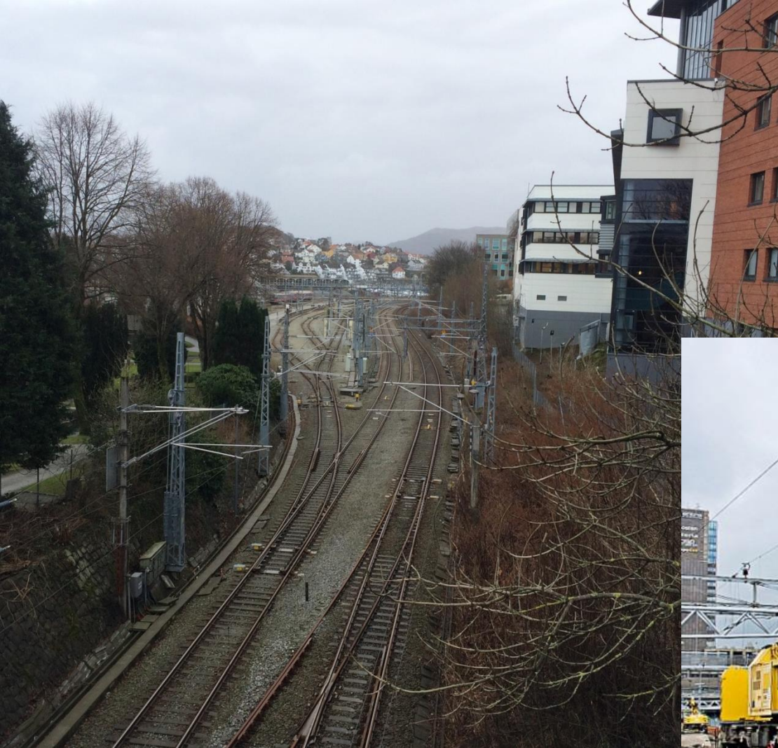
Avgreningsspor fra Jærbanen til Paradis driftsbanegård
