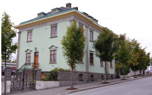
Figur 3: Administrasjonsbygget Tinnfabrikken. Foto: Byantikvaren
