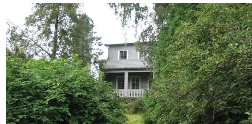
Utsikten fra (Mostun) huset mot vannet holder på å gro igjen. Det bør åpnes mot vannet og tilrettelegges for opphold. Mostun skal brukes som et naturinformasjonssenter.
