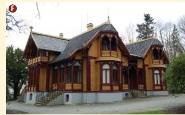
Breidablikk er uvanlig godt bevart både i eksteriør og interiør. Tegnet av arkitekt Henrik Nissen i 1881 for kjøpmann og reder Lars Berentsen. Oppført i sveitserstil med nyromanske og gotiske stiltrekk. I tilknytning til hovedbygningen står fremdeles eiendommens gamle hovedhus og låve fra 1852. Parken i engelsk stil er også godt bevart.
