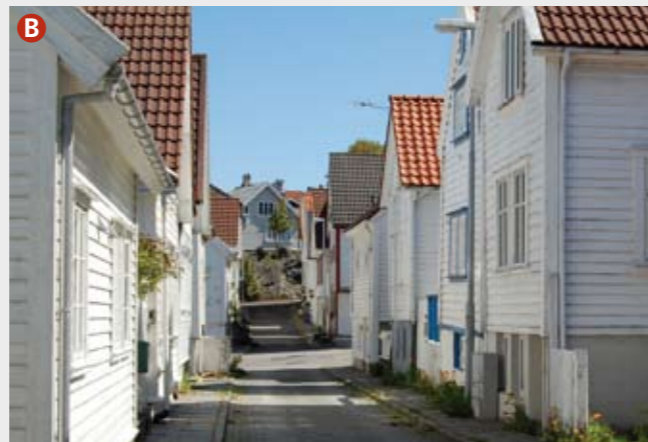
B Øvre Blåsenborg, med sine snirklete gateløp og irregulære kvartal-omriss, er et sjarmerende område som vokste fram som følge av industrialiseringen av Øste bydel. Enkle, men likevel forseggjorte, arbeiderboliger fra ca 1850-1900. Bygd i solid tømmer og kledd med liggende panel. Området kan sammenlignes med Gamle Stavanger.
