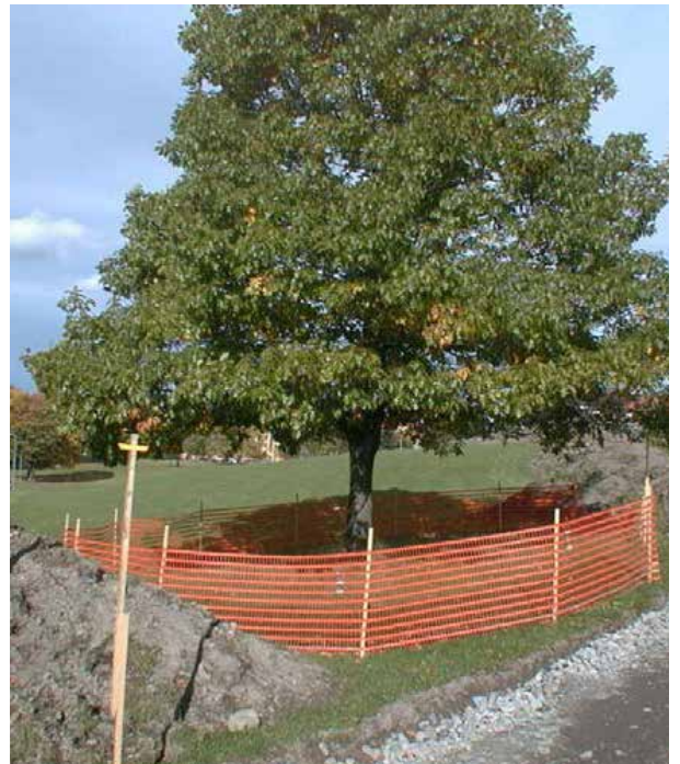
Stammebeskyttelse i form av et enkelt nettinggjerde.
