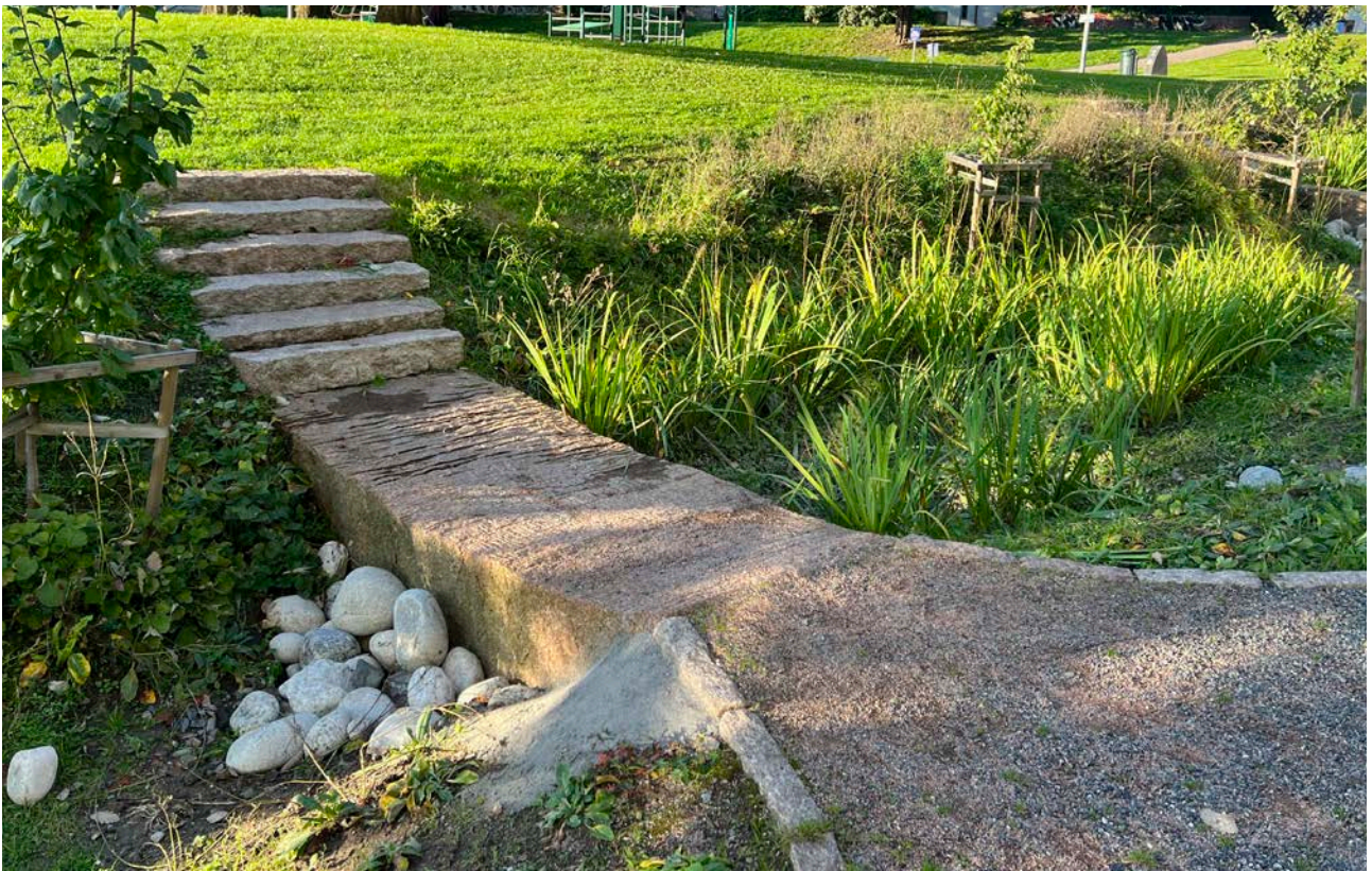
Bilde 5.8: Grøft og med tverrgående terskler som kan fungere som energi- og forsinkelseelement, Malerhaugveien, Oslo (Foto: Rambøll) Bilde 5.9: Tverrgående stein som kan fungere som energi- og forsinkelseelement, Iladalen, Oslo (Foto: Rambøll)
