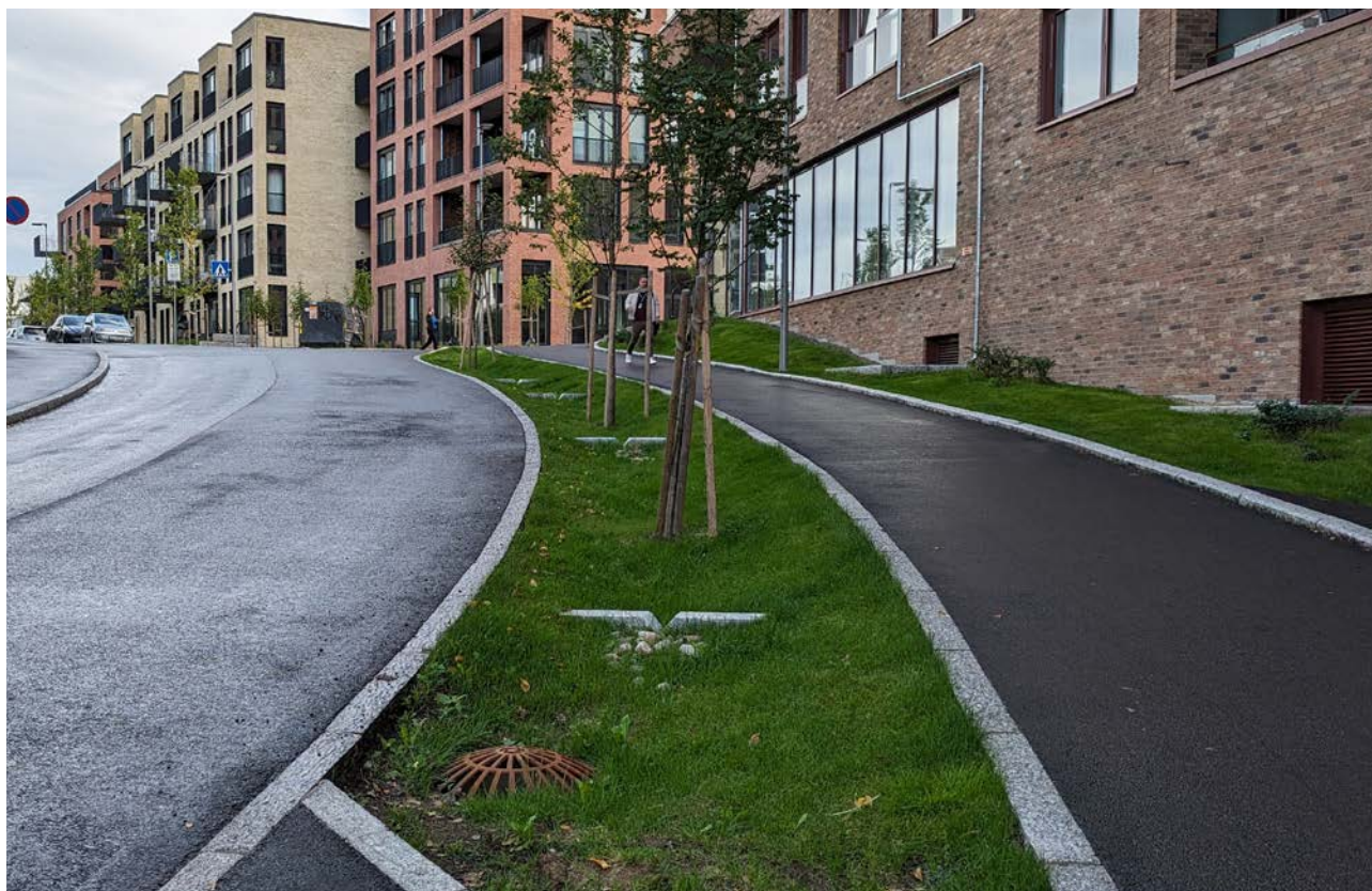
Bilde 4.7: Langsgående grøft med terskler, Malerhaugveien, Oslo (Foto: Rambøll)
