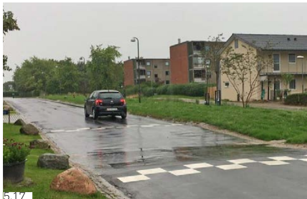
Bilde 5.14: Omvendt fartshump / fartsdump (Foto: Rambøll) | Bilde 5.15: Prinsipp med avskjærende renne med rist i Seoul, Sør-Korea (Foto: Yvona Holbein) | Bilde 5.16: Prinsipp med avskjærende renne med rist i Tsjekkia (Foto: Yvona Holbein) | Bilde 5.17: Omvendt fartshump / fartsdump (Foto: Rambøll)
