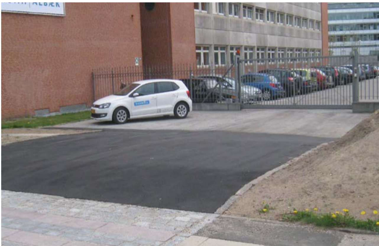
Bilde 4.10: Fartshump i Danmark etablert for å lede vann vekk fra parkeringsplass (Foto: Rambøll)
