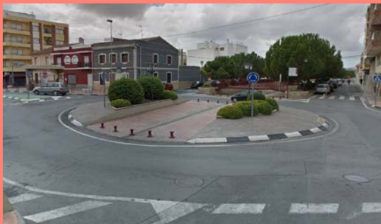
Bilde 5.10: Flomvei gjennom rundkjøringens sentraløy i Pinoso, Spania (Foto: Google Street View).
